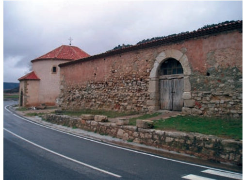
El edificio principal (almacén y procesado de la sal) y la ermita.
