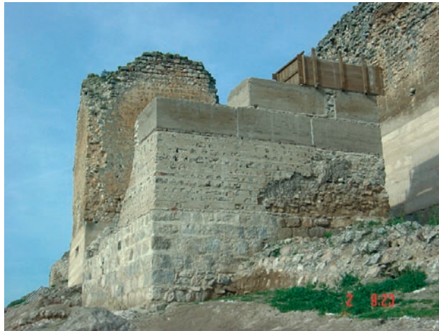
Intervención en Calatrava la Vieja. Torre albarrana. Aplicación de técnicas.
