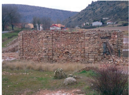
Edificio de protección de uno de los pozos y noria de extracción.
