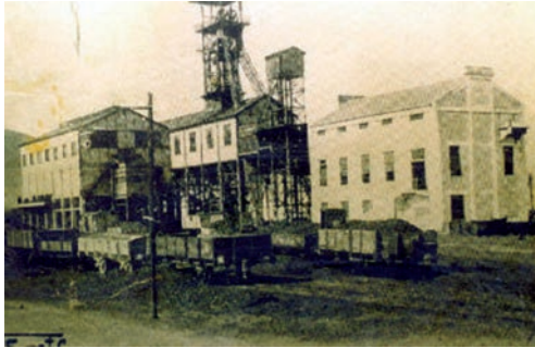
Aspecto de las instalaciones del Pozo Norte en los años sesenta del siglo XX
