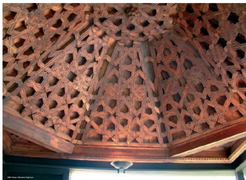
Figura 2. La armadura de lazo in situ y tras la restauración en su ubicación actual
