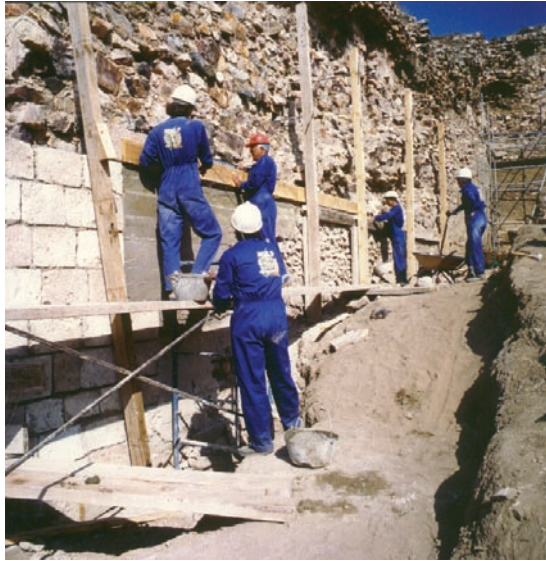
Intervención en la muralla de Alarcos.
