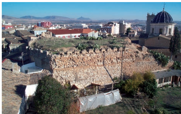
Fig. 5.- Castillo de Caudete antes de iniciar los trabajos de restauración
