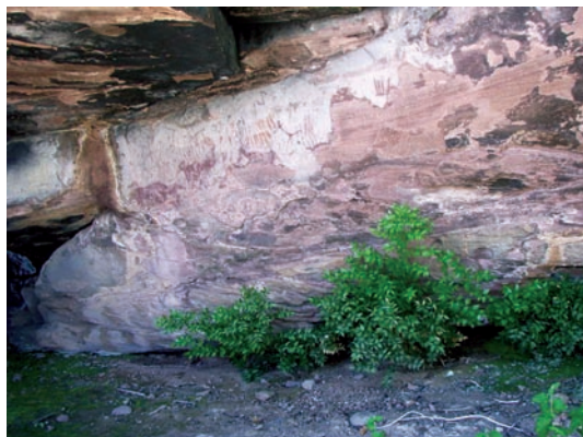
Perspectiva del panel 2 de Cueva del Tío Modesto (Henarejos) en la que se aprecia como la retención de humedad está provocando la aparición de musgo en el suelo y de matas de ruscos.
