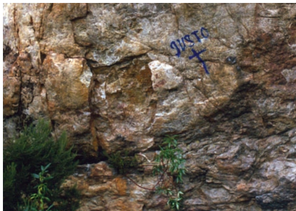
Garganta del Muerto (Solana del Pino). En esta imagen se pueden apreciar las agresiones que han sufrido estas pinturas: extracción del panel de pinturas y grafito con pintura plástica.
