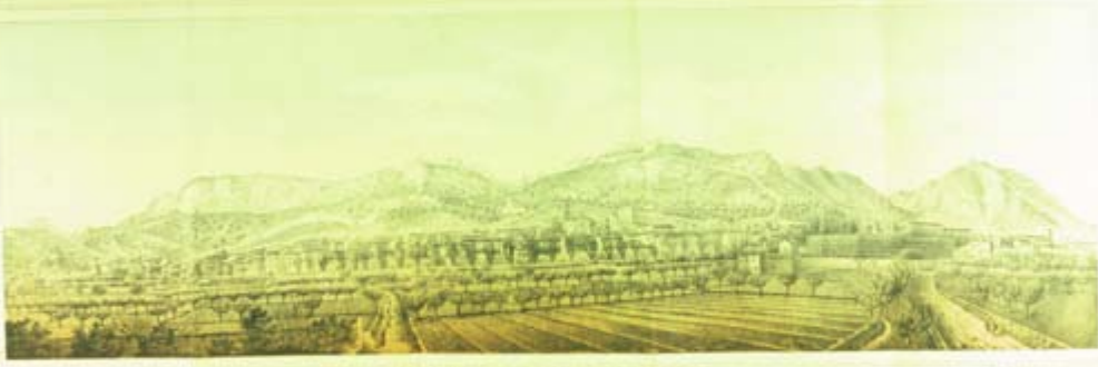
VISTA GENERAL DE ARTIVA.
