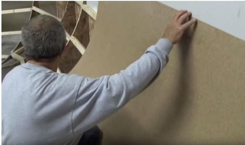
Figura 6.51 Construcción de las uniones entre pared y suelo del ciclorama.
