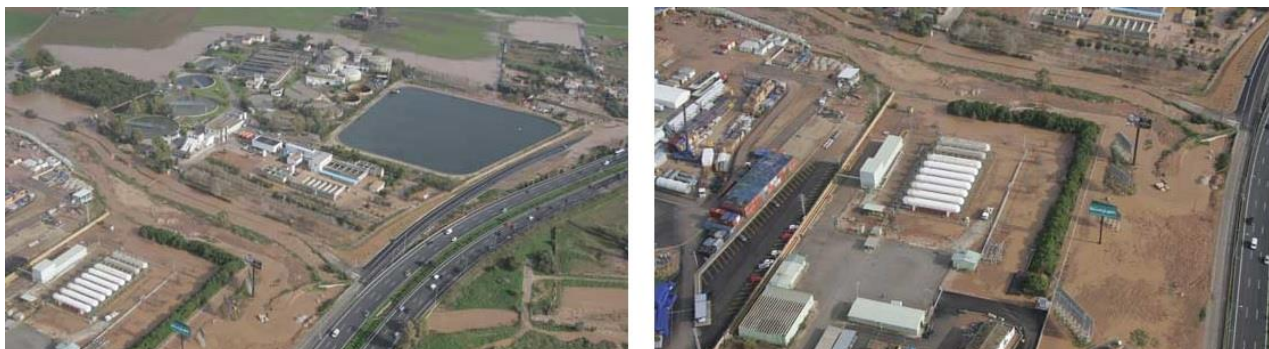
Figura 6: imágenes de la central depuradora EDAR – Palma I y II afectadas por inundaciones. Se puede ver la balsa donde se acumulan las aguas que usan los agricultores para regar sus cultivos. Imágenes cedidas por el IGME.
