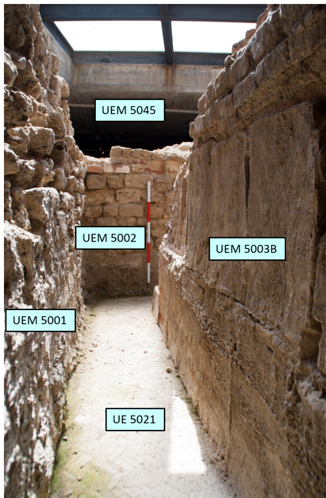
FIG. 13. Ángulo SE del canal interior de la letrina -UE 5045- visto desde el norte, delimitado por el muro UEM 5001 y el ci- miento de apeo del banco de las letrinas UEM 5003, forrado por dos hileras de tégulas -UEM 5003B = 5004B- y con varias hiladas de ladrillo superpuestas. El suelo de opus spicatum de la piscina precedente -UE 5021- es la base del canal. Se aprecian dos niveles de concreciones calcáreas en la tégula inferior (Morillo, Durán y Martín Hernández).
