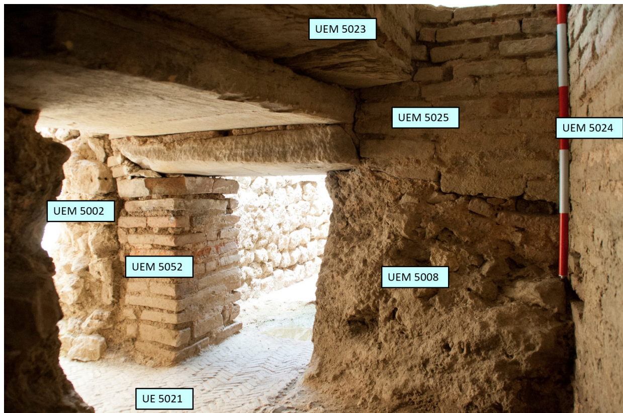
FIG. 25. Vista general del sector meridional de la excavación, completamente modificado durante la tercera fase constructiva, durante la cual se abre un nuevo colector (UE 5026) y se reconstruyen los muros en ladrillo. Al fondo se aprecia la superposición de losas que actúan como cargadero y soportan el forjado del patio UE 5023. El jalón se apoya en el muro perimetral de la antigua piscina del frigidarium, roto y arrasado para encajar la nueva cloaca UE 5026 (Morillo, Durán y Martín Hernández).
