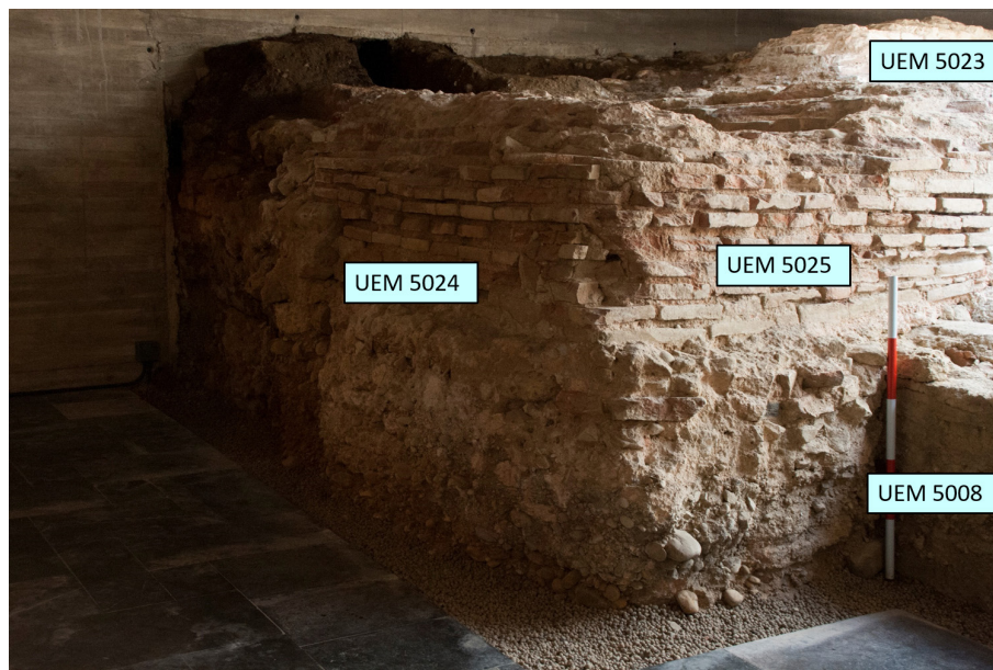
FIG. 22. Lateral meridional del edificio, tal y como se encuentra actualmente musealizado (UEEEMM 5025 y 5024); se aprecia tanto el cimientado de opus caementicium, actualmente a la vista, como su alzado en opus testaceum que corresponde a la tercera fase constructiva (Morillo, Durán y Martín Hernández).
