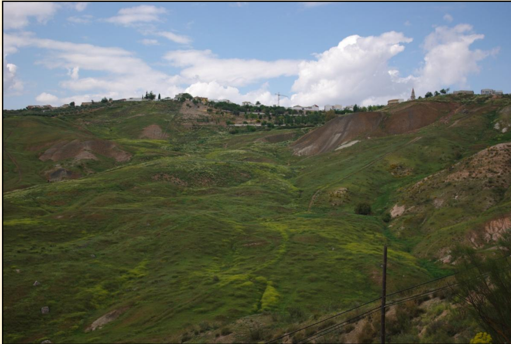
Deslizamiento de Benamejé, Cordoba
