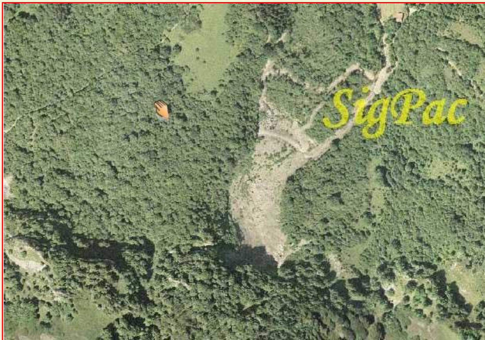
Desprendimiento y colada de Intza, Navarra
