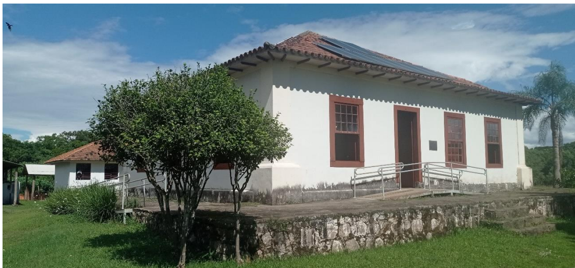
Centro Cultural Casarão (foto del autor)
