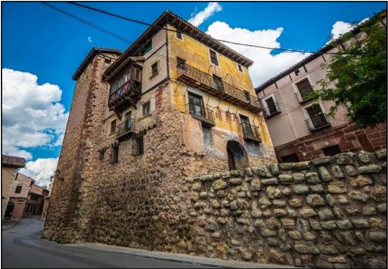
Murallas de Molina (Puerta del Baño)
