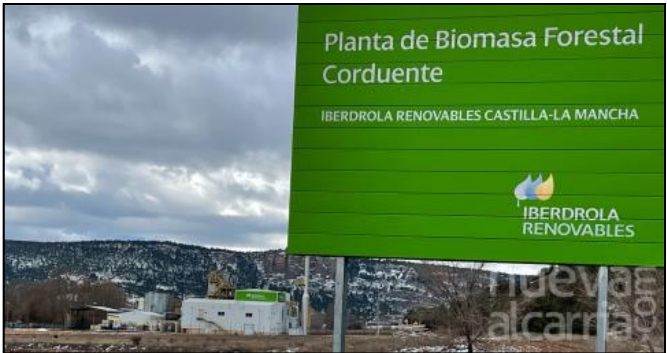
Planta de biomasa de Corduente
