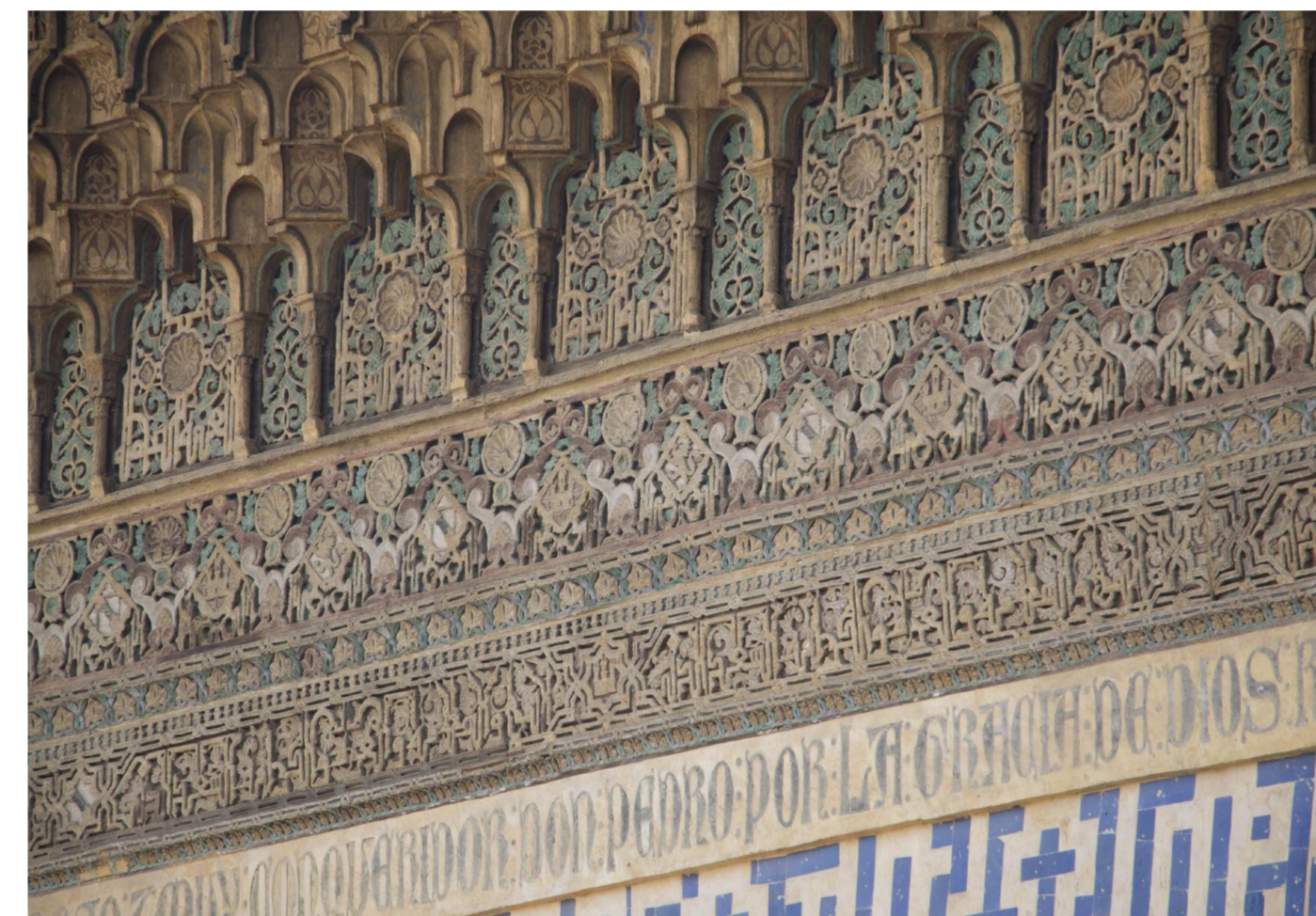
Detalle de la fachada del Palacio de la Montería, 1355 - 1365, Reales Alcázares, Sevilla.
