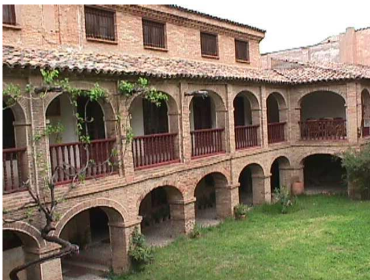
Fig. 9. Galería de la casa de los Navascués
