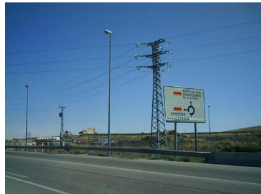
Figura 13 Ampliación carretera M-609
