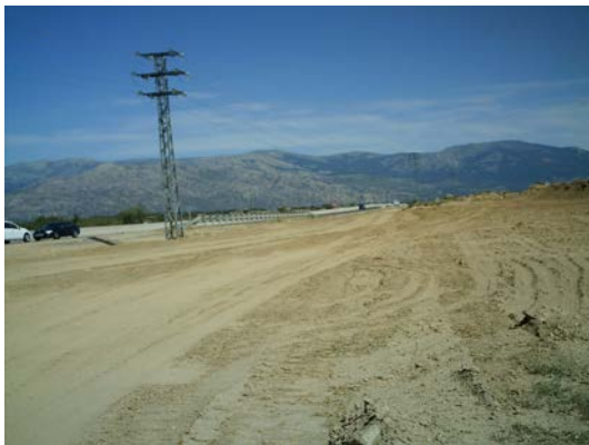
Figura 12 Ampliación carretera M-609
