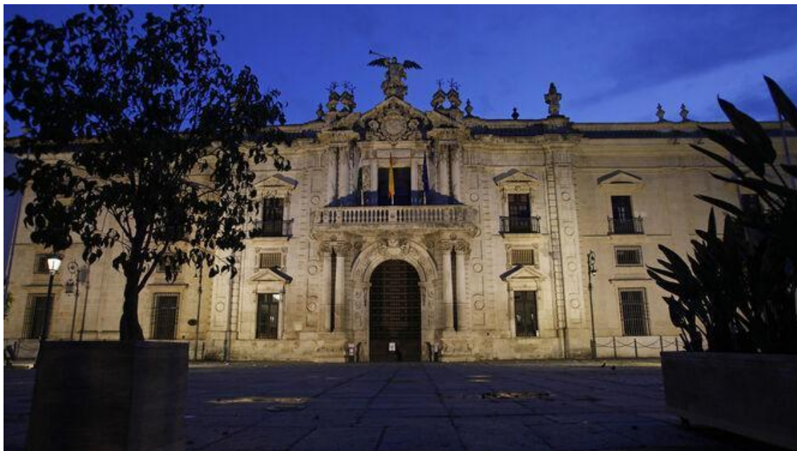
Figura 5 Fachada principal de la antigua Fábrica de Tabacos, Rectorado de la Universidad de Sevilla
