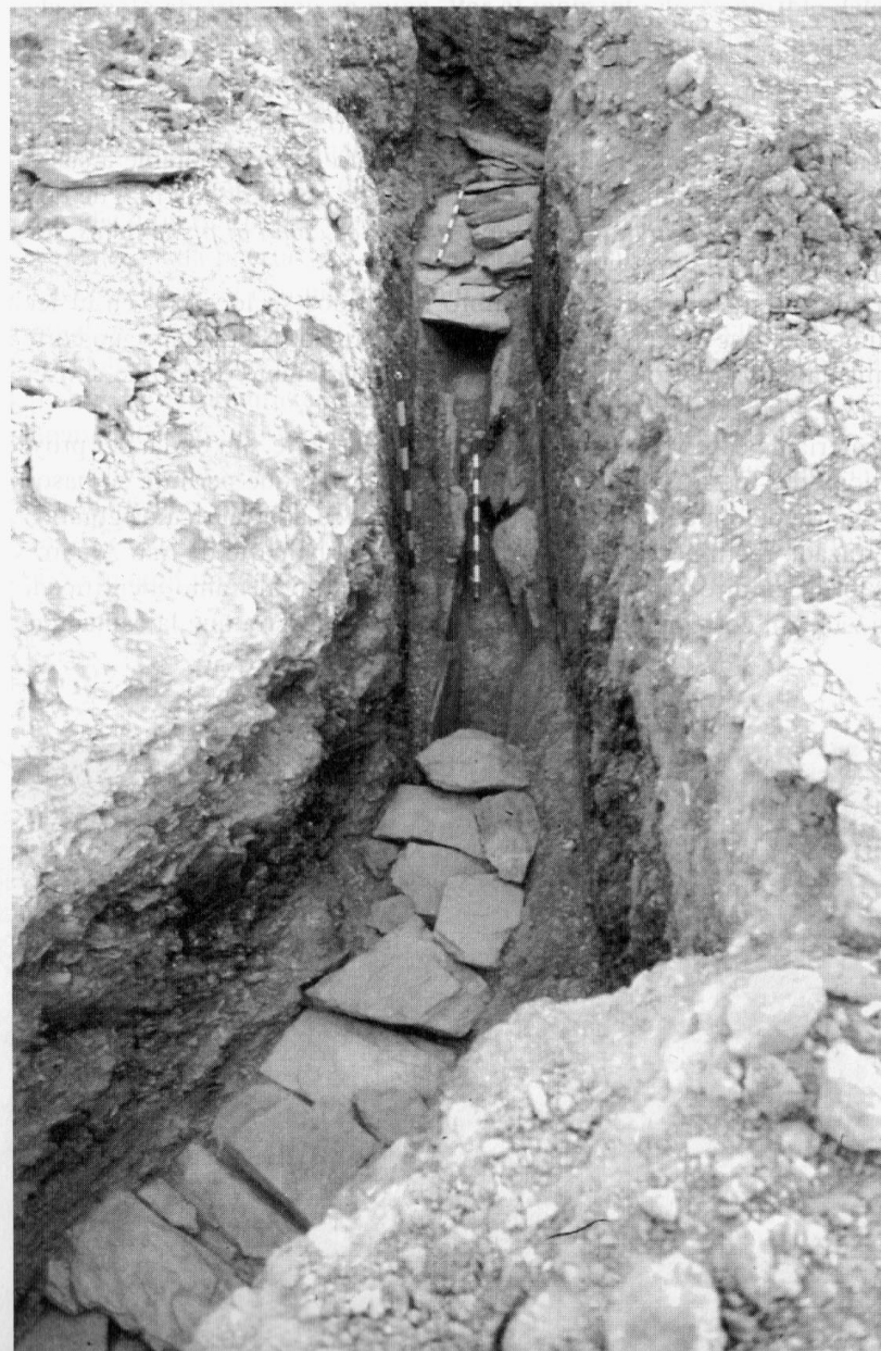
LÁM. 5. Atarjea de evacuación de aguas.
