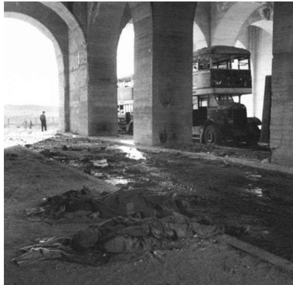
Figura1. Viaducto de los quince ojos, Ciudad Universitaria, Madrid 1936. Primer visionado de la fotografía Marzo de 2010 en http://madrid1936.es/universitaria/construccion.html
