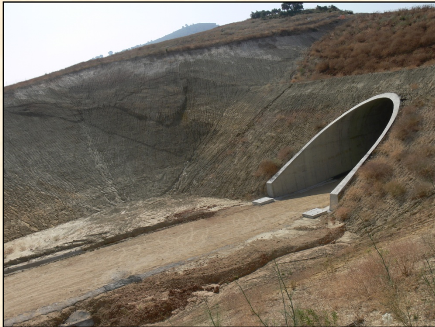
Flujos en el emboquille del AVE a Málaga
