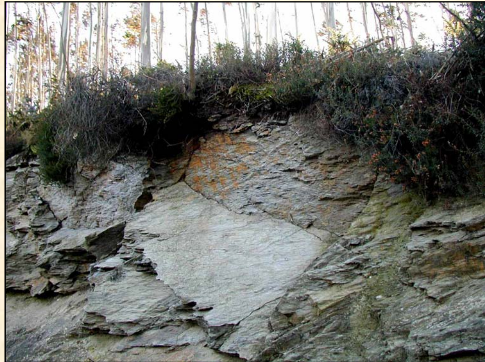
Deslizamiento planar en “cuña”, Asturias
