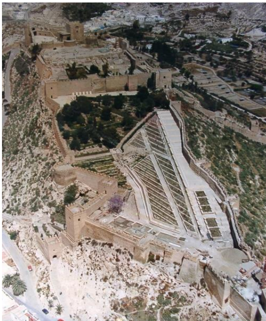
Fig. 3.17. La Alcazaba de Almería durante las obras de restauración del primer recinto. Foto CMAA.
