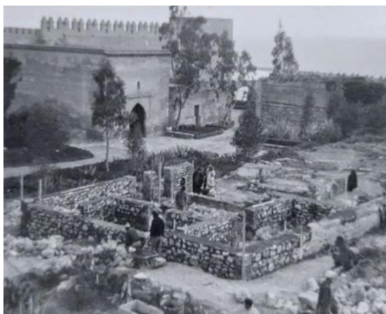
Fig. 3.14. Construcción de las “casas islámicas” en 1968 (Foto CMAA).
