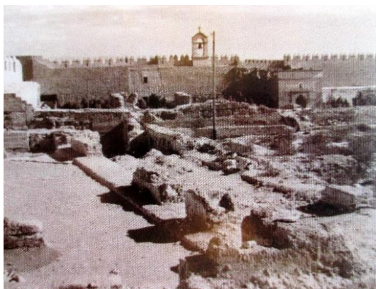
Fig. 3.8. Estado de las estructuras excavadas en el segundo recinto tras su relleno en los años 50. Según Suárez Márquez (2012: 33).
