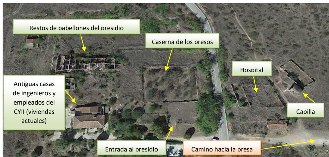
Vista aérea detalle de las instalaciones del presidio (2)
