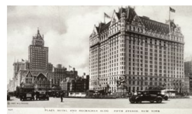
Fig. 35 - El MoMA se inauguró el 7 de noviembre de 1929 y estuvo situado en la planta doce del edificio Heckscher (edificio de la izquierda). Dominio público
