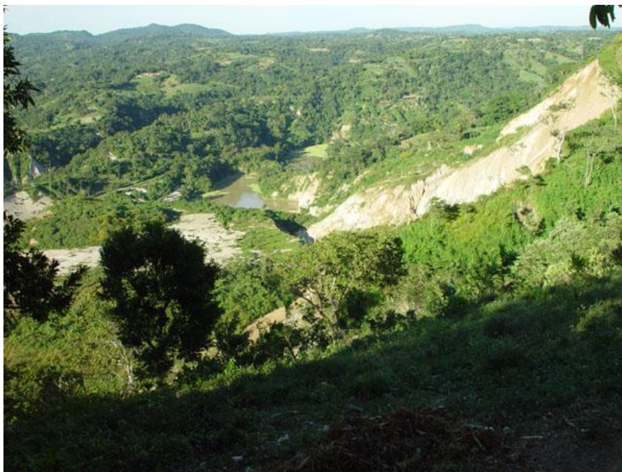
Figura 2 Fotografía desde el escarpe del deslizamiento. Nótese el represamiento del río en la parte central. (Jenkins, 2001)
