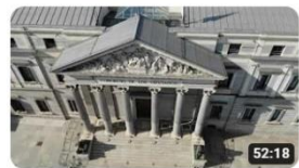
El Paisaje de la Luz a vista de pájaro. Edificios
