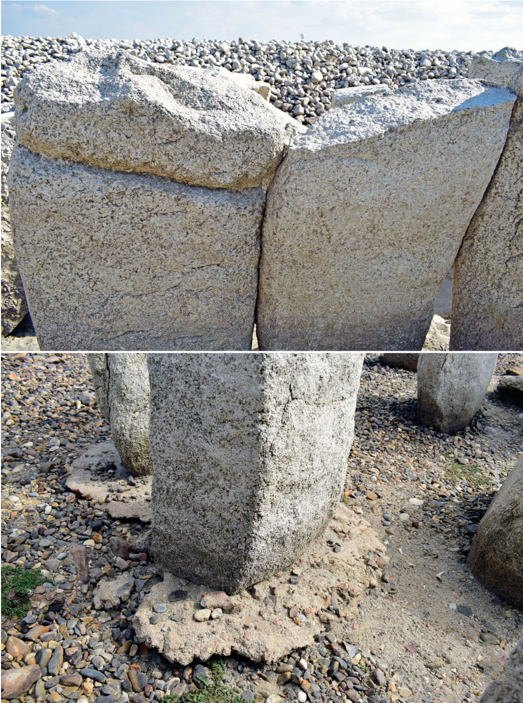
Figura 14. Evidencias de la restauración de Obermaier en Guadalperal. A. Cosido de ortostatos. B. Bases de hormigón de los soportes del sistema de contrafuertes
