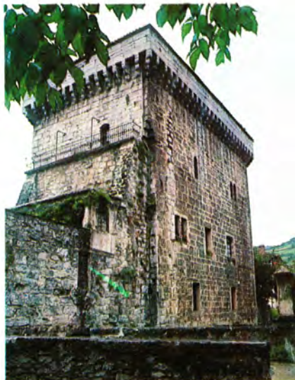
La torre Zabaleta de Lesaka, mansión-fortaleza.
