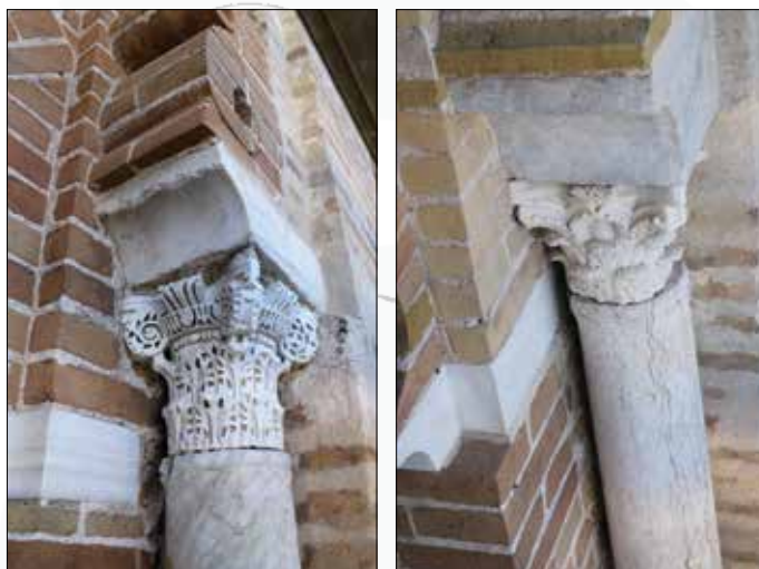
Fig. 4. Capiteles reutilizados en una de las fachadas del alminar de la mezquita aljama almohade de Sevilla (Giralda).
