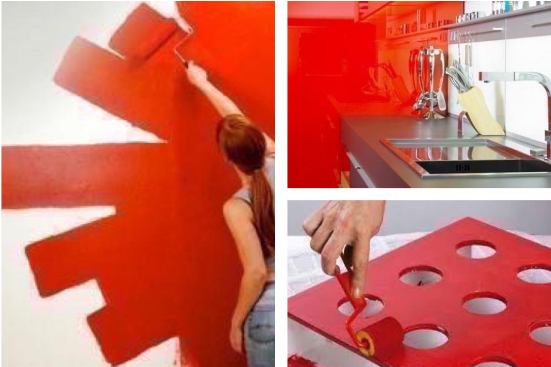
Detalle de la aplicación de esmaltes y barnices sobre distintas superficies.
