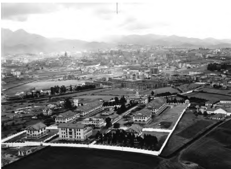
Figura 6. Vista aérea del Hospital Psiquiátrico de La Cadellada desde el noreste, 21 de septiembre de 1962, con la ciudad de Oviedo al fondo. 44
