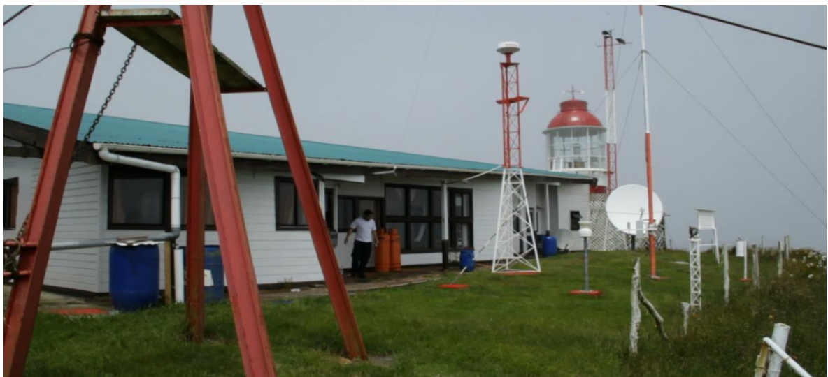
Figura 11.2. Vemos en el fotograma superior una vista desde el lado sur de las instalaciones. En el inferior, desde el lado norte, se aprecian instrumentos para medición climática y antenas de Tv. Fotogramas centrales: exterior e interior de la torreta del faro. (Isla Guafo enero 2013-2015).
