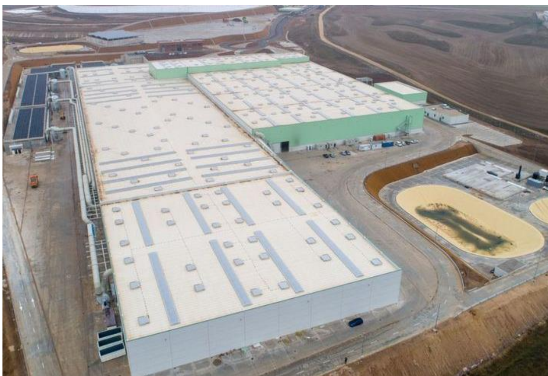
Fig. 1. Fotografía de la planta de gestión de residuo de Loeches que muestra la inaccesibilidad de los residuos para las aves que supone el cambio de gestión de los vertederos. Fuente: madridiario y FCC.
