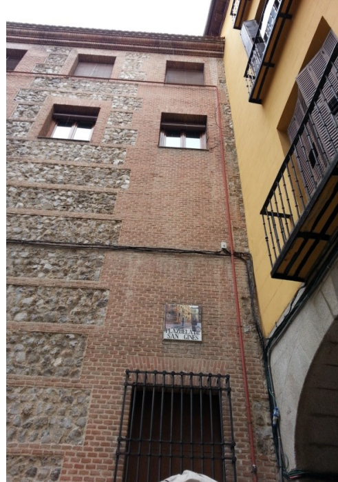
27. Conducción de gas que discurre por la fachada sur. Foto: Sergio Boj.
