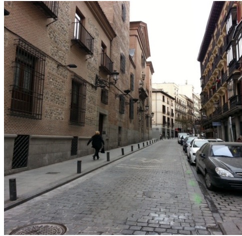
30. Bolardos instalados en uno de los laterales de San Ginés. Foto: Sergio Boj.
