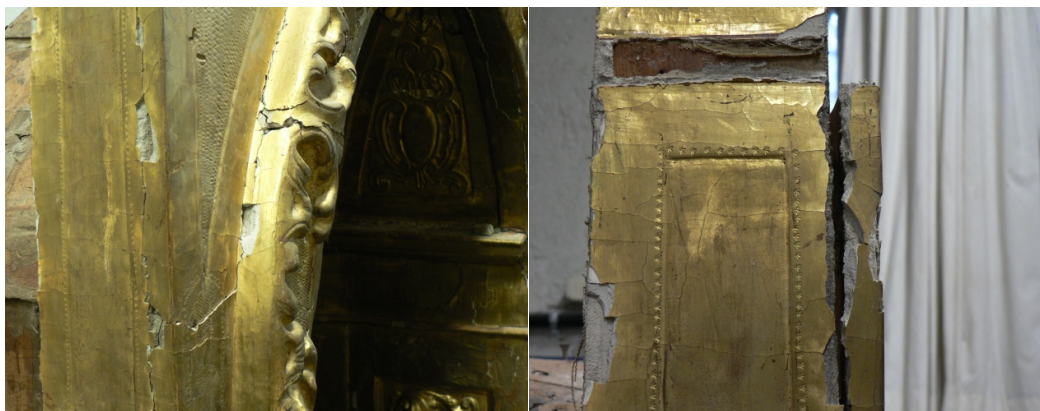
14. Detalles de un retablo propiedad de la Diócesis de Cuenca donde puede observarse el desprendimiento de dorados y capas preparatorias a causa del agua. Foto: Montaña Galán.
