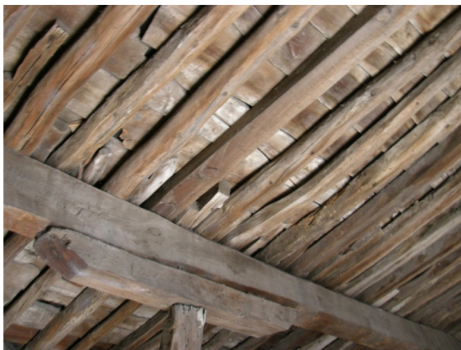
1. Detalle de la bajo-cubierta de la Catedral de Ávila donde se puede observar un ejemplo de elementos arquitectónicos en madera sin tratamiento ignífugo. Foto: Sergio Boj.
