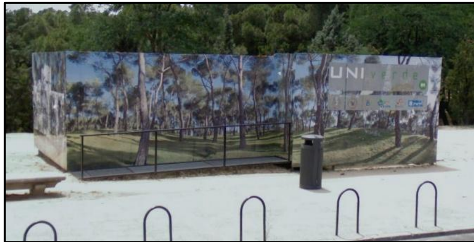
Figura 7.4 Instalaciones UNIVERDE Paraninfo Norte – C. Universitaria
