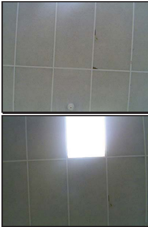
Figura 15 Fotografías del techo de la FDI
