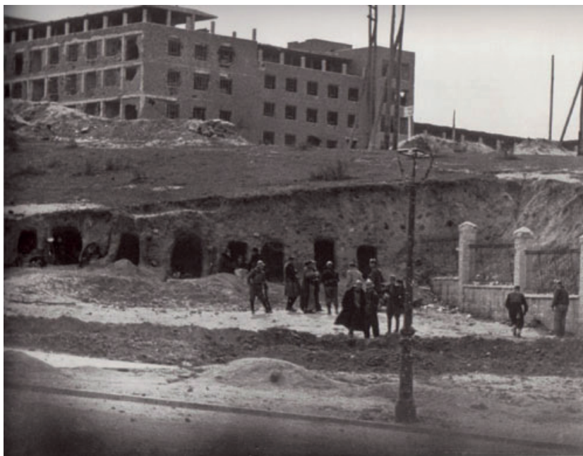
Figura 26. (Fondo Otto Wunderlich del IPCE). En esta imagen pueden advertirse los accesos a los túneles y galerías que discurrían bajo el Hospital Clínico.
