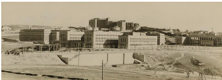
Figura 36. (UCM. Colección Aniversario de la Junta Constructora de la Ciudad Universitaria). En primer término, puede apreciarse claramente el contrafuerte de Torroja, colmatando el Arroyo Cantarranas, y detrás, el Grupo Médico, con el Hospital Clínico dominante sobre el Cerro del Pimiento.
