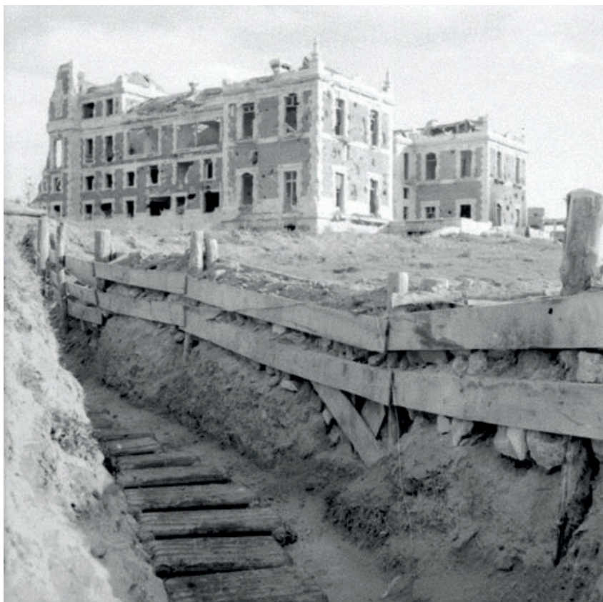
Figura 10. (Albert Louis Deschamps) En esta imagen puede apreciarse el interior de las trincheras ubicadas en la fachada noreste de la Casa de Velázquez y el empleo de radiadores como pavimento.
