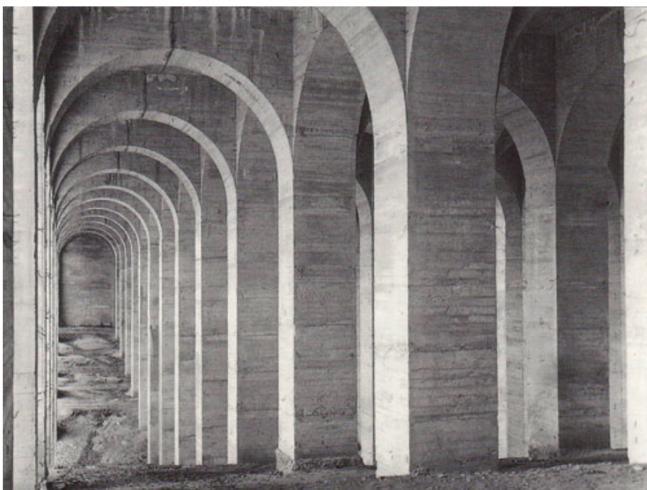
Figura 38. (Albert Louis Deschamps). Vista lateral de las arcadas.
