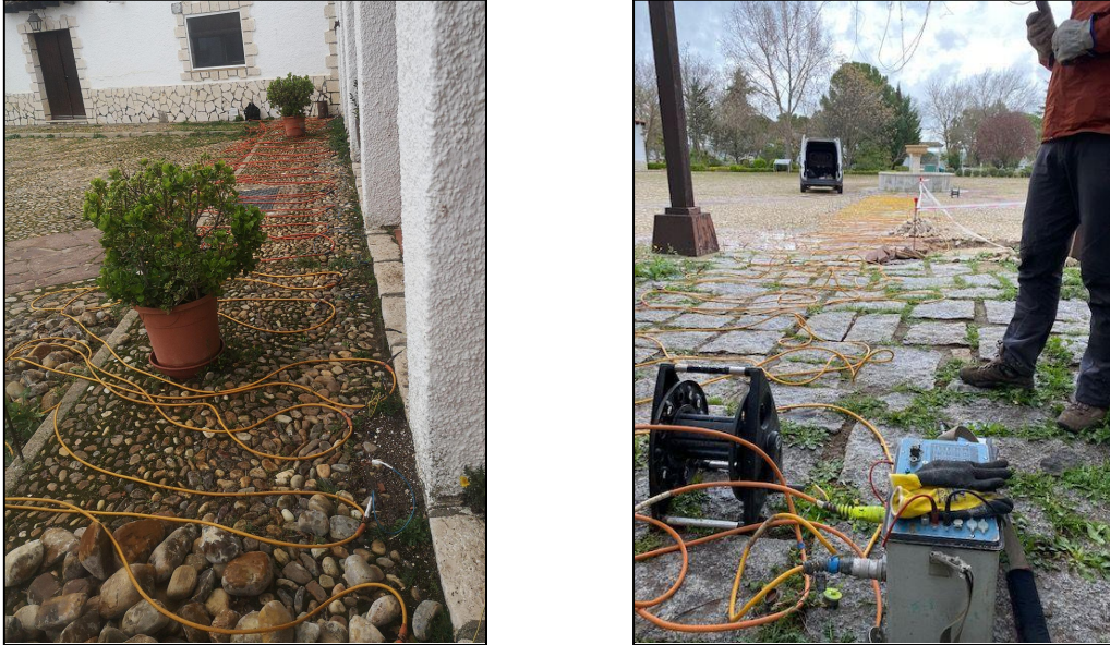
Fig. 10: Imágenes en las que se observa el retranqueo realizado en cada cable, para hacer coincidir sus conexiones con la separación de electrodos previamente definida.
