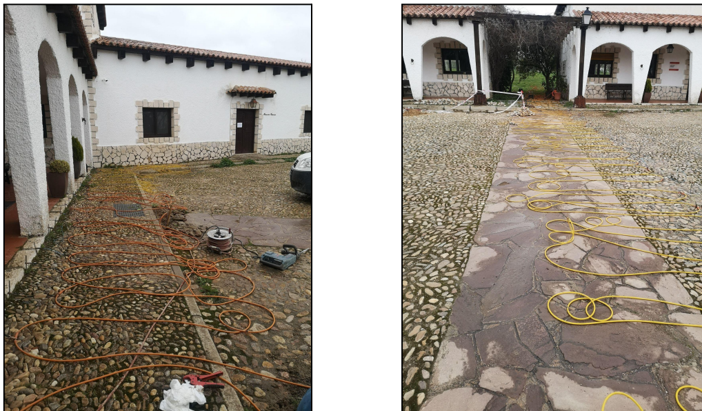
Fig. 9: Imágenes tomadas en la zona de estudio, en las que se observa la superficie del terreno compuesta por solera.
