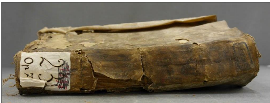
Fig.29. Suciedad adherida al lomo exterior de la cubierta.
