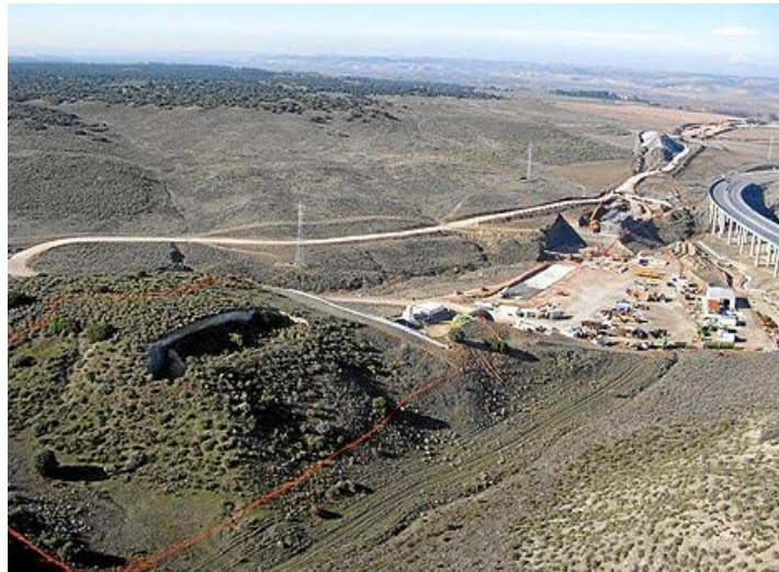
Figura 41: Construcción del túnel de El Ragajal
