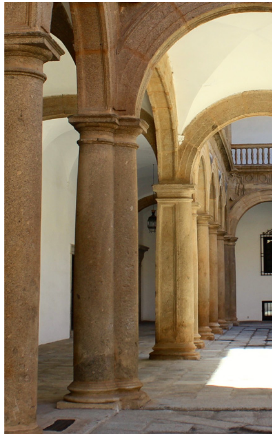
Fig. 55: Solución de esquina del orden toscano del hospital Tavera. Fotos: Manuel Parada y Antonio Sánchez-Barriga.
