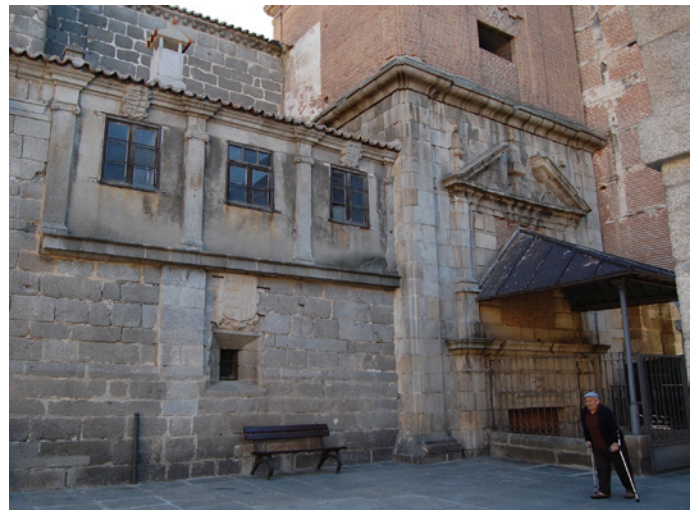
Fig. 99: Tribuna –ahora tapiada parcialmente– de los Dávila en la iglesia de San Juan hacia el Mercado Chico. Foto: Manuel Parada.
