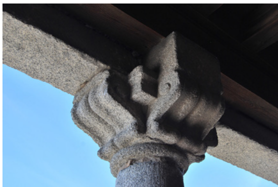
Fig. 90: Zapata con ménsulas dobles en el balcón llamado de Guiomar, palacio Dávila. Foto: Manuel Parada.
