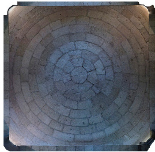
Fig. 69: Bóveda plana del sotocoro del monasterio de El Escorial. Fotos: Enrique Rabasa y Marta Perelló.
