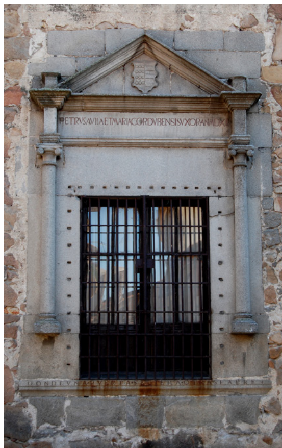
Fig. 91: Ventana monumental del palacio Dávila. Foto: Manuel Parada.
