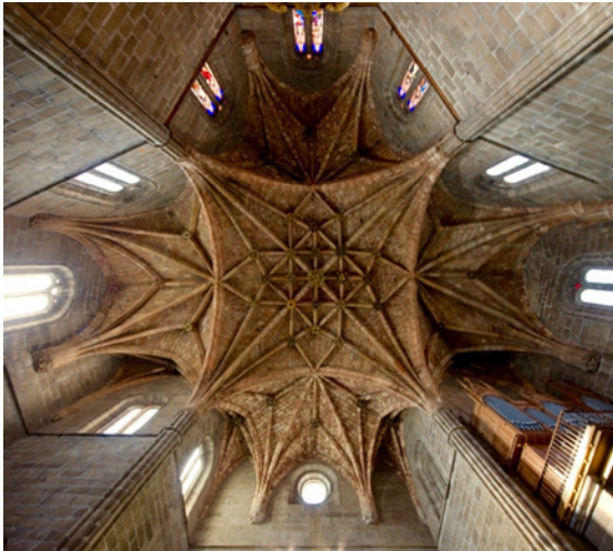
Fig. 134: Bóveda estrellada de la capilla de Mosén Rubí, Ávila. Foto: Eduardo Mascagni.
