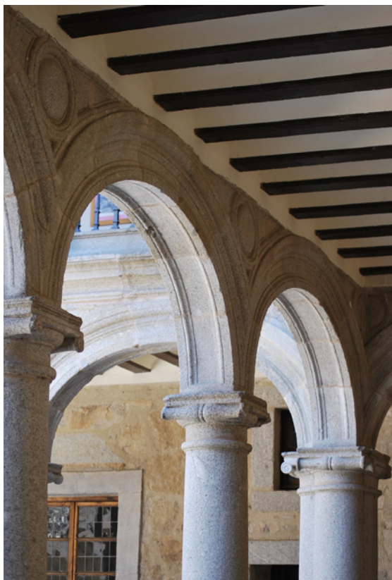
Fig. 58: Galería inferior del patio del castillo-palacio Magalia. Foto: Manuel Parada.
