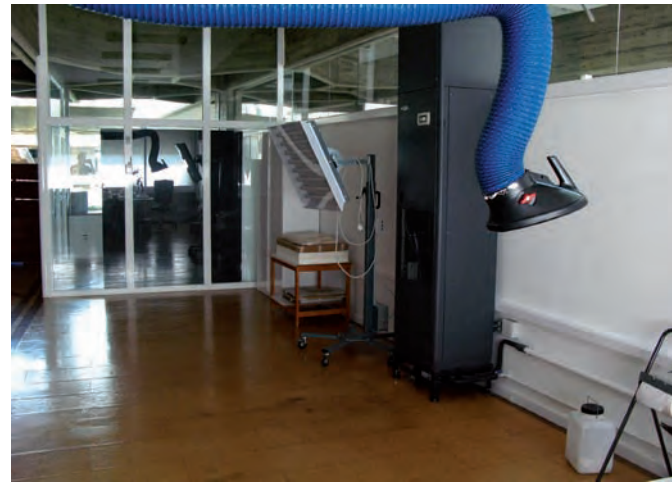
Figuras 1 y 2. Interior de la Sala Acondicionada 2. En ambas imágenes se puede ver el sistema de climatización, a modo de torres, y el sistema entálpico de renovación de aire con bocas de aspiración localizada.
