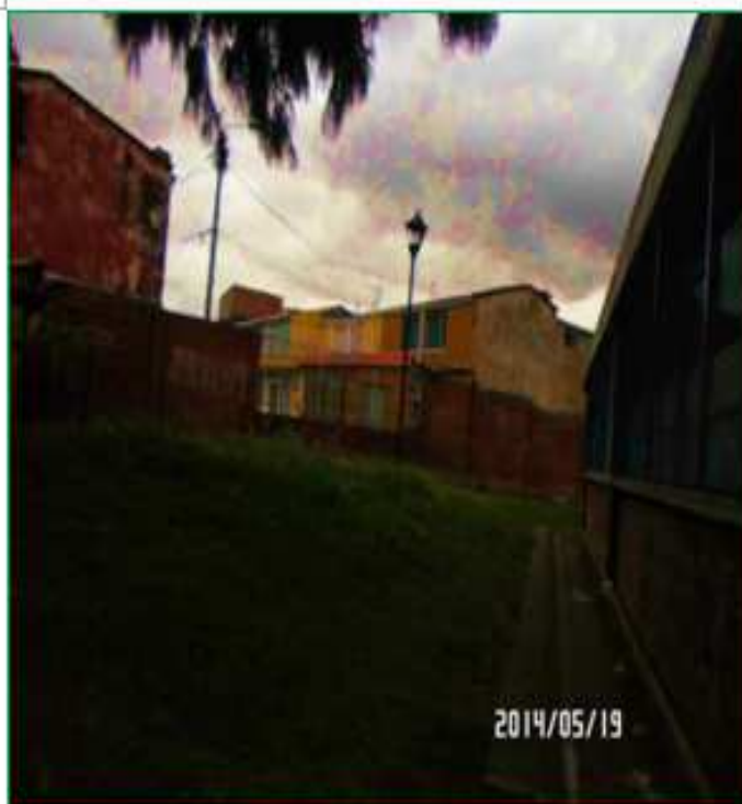
Parte trasera del colegio que da contra casas vecinas.
