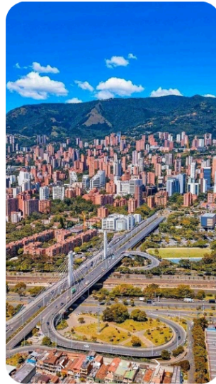
Figura 12. Panorámica del puente de la 4 sur, El Poblado Fuente: https://www.tiktok.com/@tiktokdecolombia/photo/7270498454244281642
