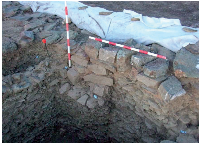
Figura 15. Pormenor construtivo do paramento exterior da muralha do acampamento, constatado na campanha de 2015. Na imagem pode ver-se a adaptação da espessura da estrutura resultante da construção realizada por distintos manipulos. Fotografia de José Ángel Salgado Carmona.
