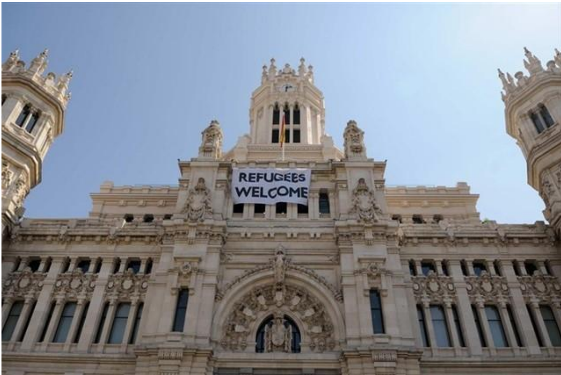
Imagen 3 Fachada Ayuntamiento de Madrid
