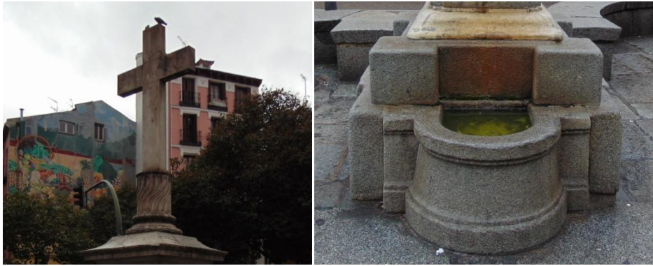
FIG. 30 y 31. Suciedad superficial y ennegrecimiento.
