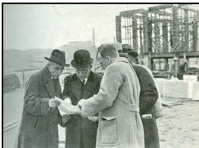
Aguilar, Secretario General de la Junta Constructora de la Ciudad Universitaria, Consultando los planos sobre el terreno.
