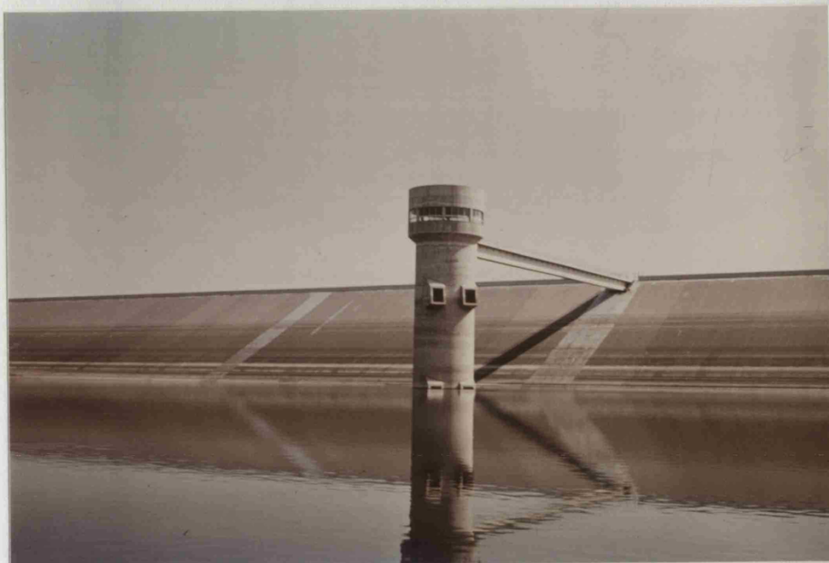
Foto 1.- Torre de toma el 26 de Agosto de 1981, la segunda toma ya es visible
