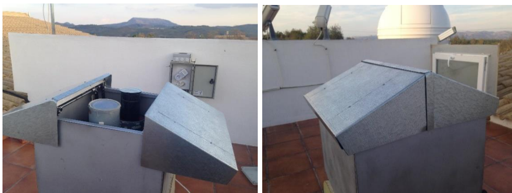
Figura 24. Módulo automático con sistema de apertura/cierre para protección de las cámaras.
