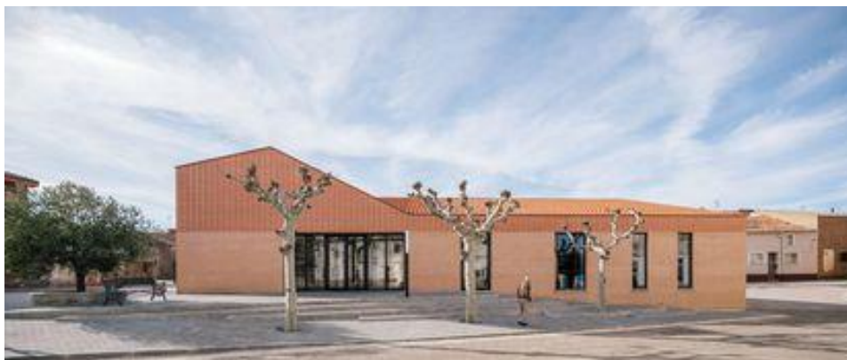
Figura 15. Rehabilitación del teleclub de Noviercas.
