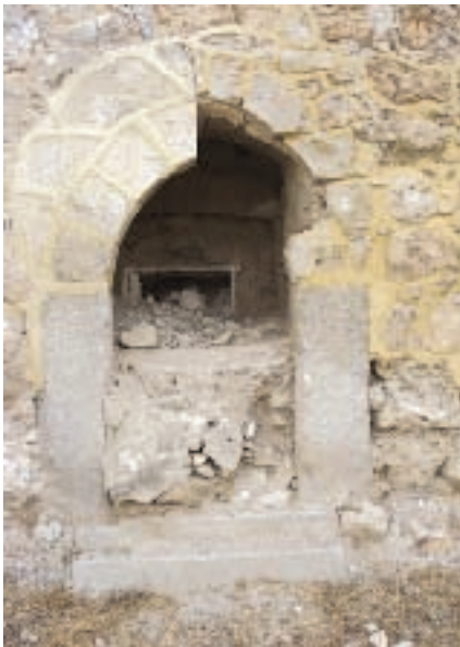
Figura 6. Materiales de construcción utilizados en el castillo de Torrejón de Velasco, Madrid. Se distingue el granito, la caliza, el sílex y diversas tipologías de morteros de junta.
