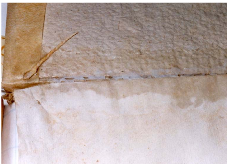
Fig. 8 El tono blanco del adhesivo revela la presencia de cola blanca en otras reparaciones
